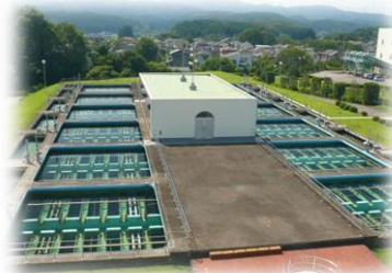
松田新田浄水場
