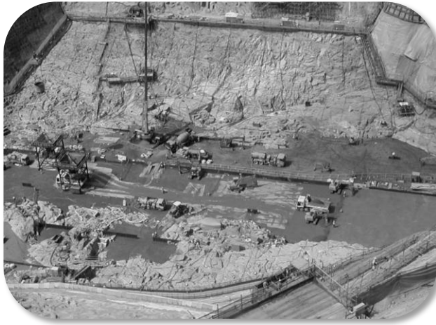
湯西川ダム建設現場
