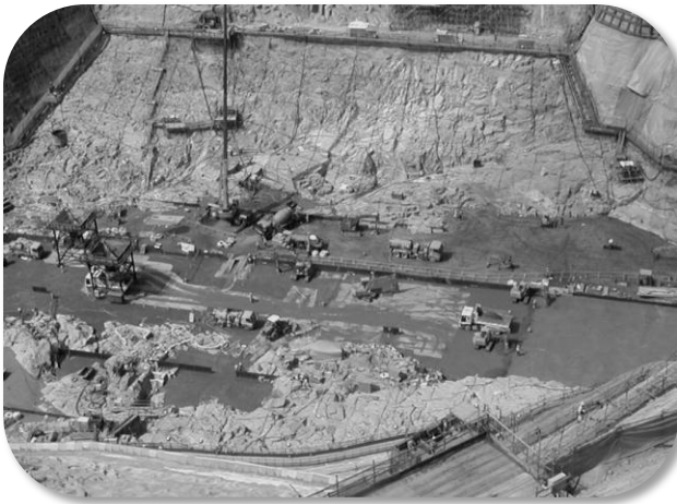
湯西川ダム建設現場
